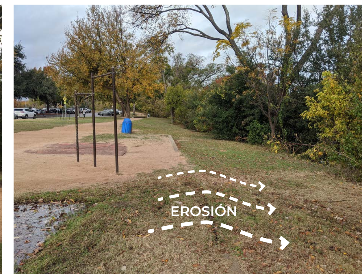
EROSIÓN EN EL MURO DE CONTENCIÓN EXISTENTE
